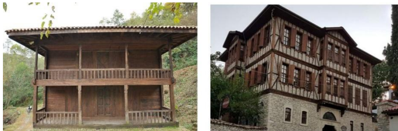
Fig. 1. Timber masonry and timber frame system (Meyveli Köyü Camii, 2025; Yalçın et al., 2022)
